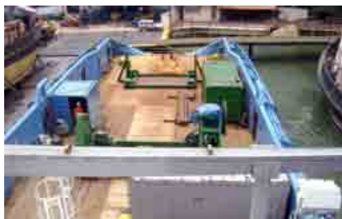
Início da montagem dos equipamentos.
