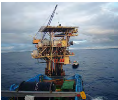
Plataformas PGA-3 e o lançamento do cabo óptico.
